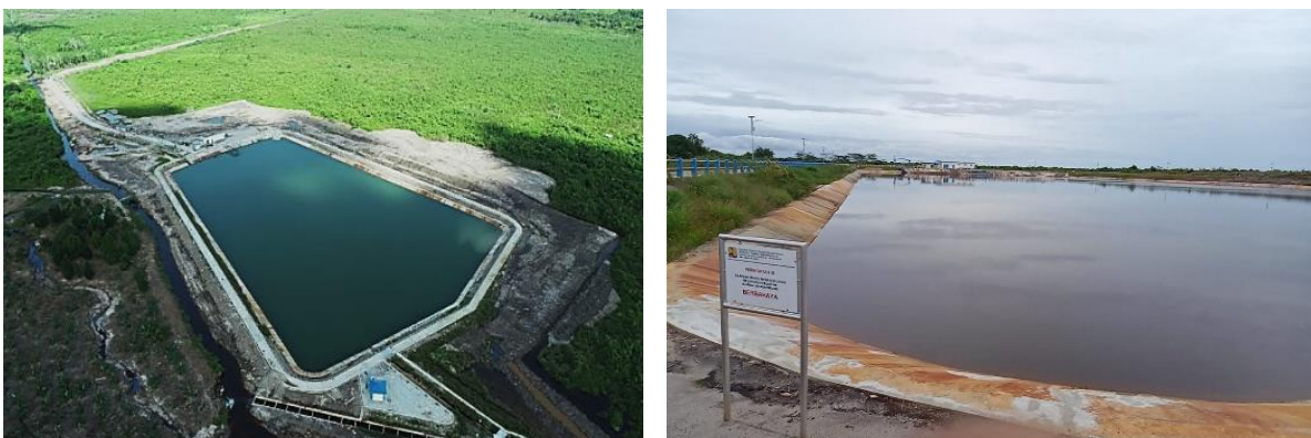
Gambar 2 Kondisi Eksisting Embung
