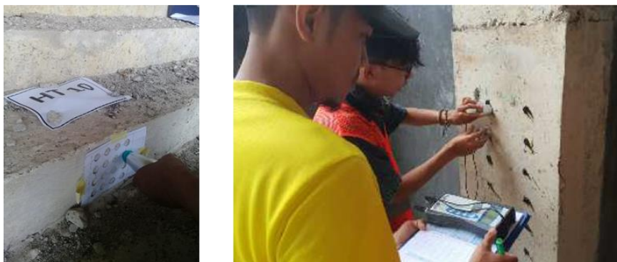
Gambar 4. Pengumpulan data mutu beton ( undestructive test )
