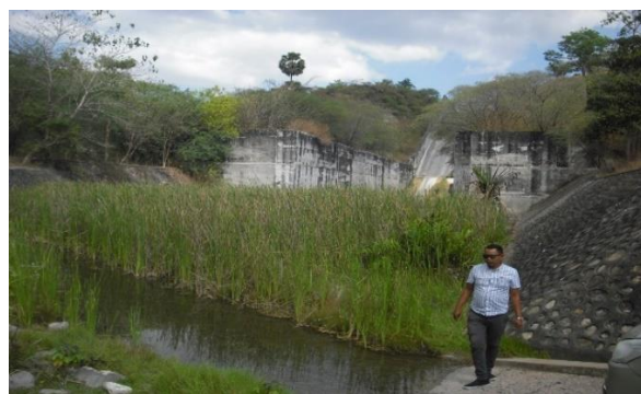
Gambar 2. Kondisi saluran spillway bagian hilir
