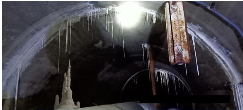
Gambar 3. Kondisi terowongan pengeluaran
