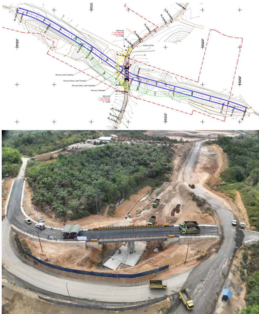
Gambar 1. Jembatan gelagar komposit A30 Persimpangan Underpass Bekambit
