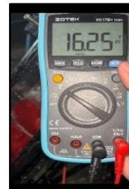
Gambar 3. Pengukuran Daya tegangan
