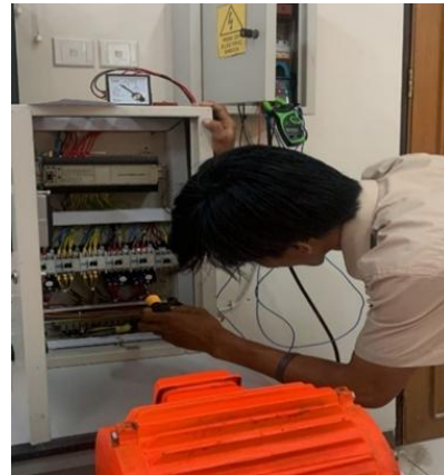
Gambar 5. Setting Trip Arus Lebih Pada TOR
