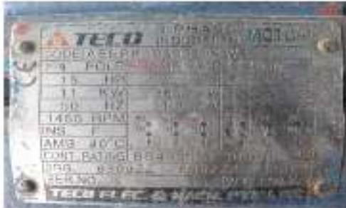
Gambar 5. Name Plate Motor Induksi 15HP
