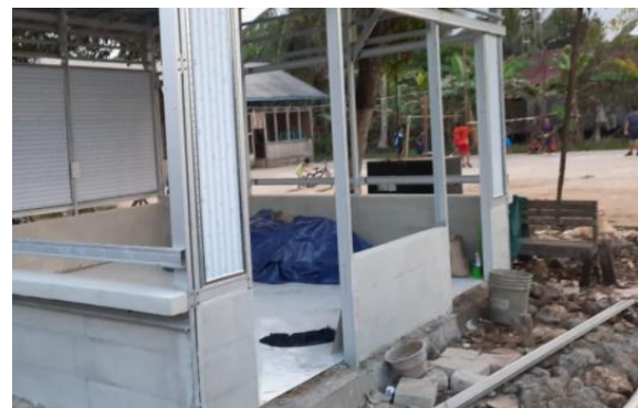
Gambar 3-Proses pembangunan taman bacaan
