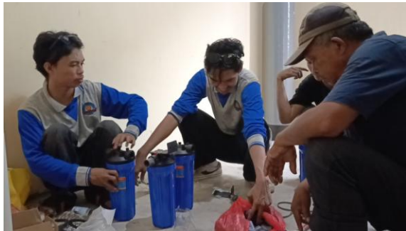
Gambar 6. Pemasangan teknologi penyaring air
