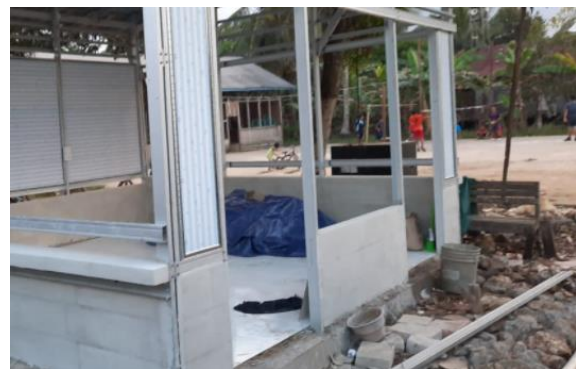
Gambar 3-Proses pembangunan taman bacaan
