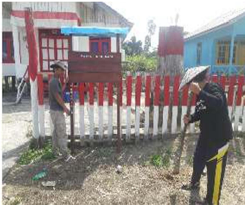
Gambar 5. Proses Pemasangan Papan Informasi Di Kantor Desa
